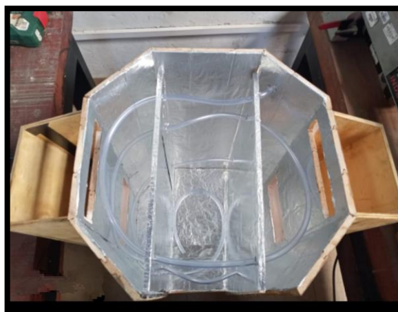
Figura 11: Instalación de sistema de aislamiento
