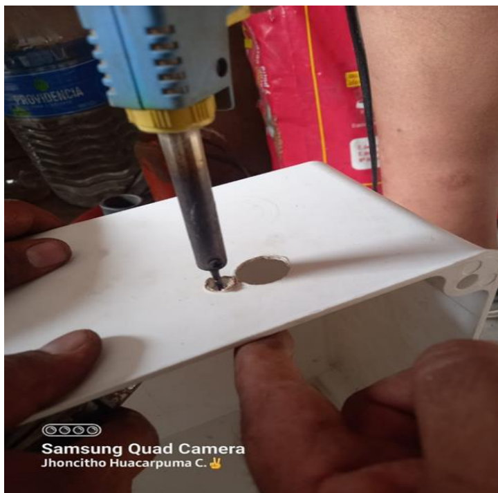
Figura 14. Acondicionamiento de base para el sensor CKP
