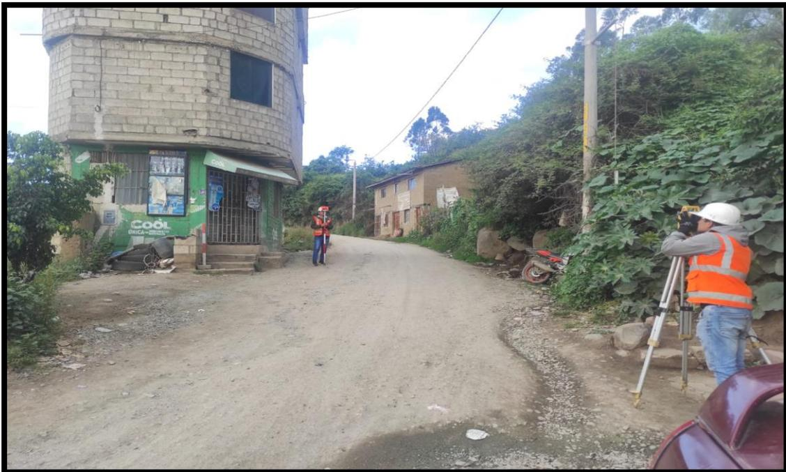
*Foto 14. Levantamiento topográfico del lugar (2022)*
