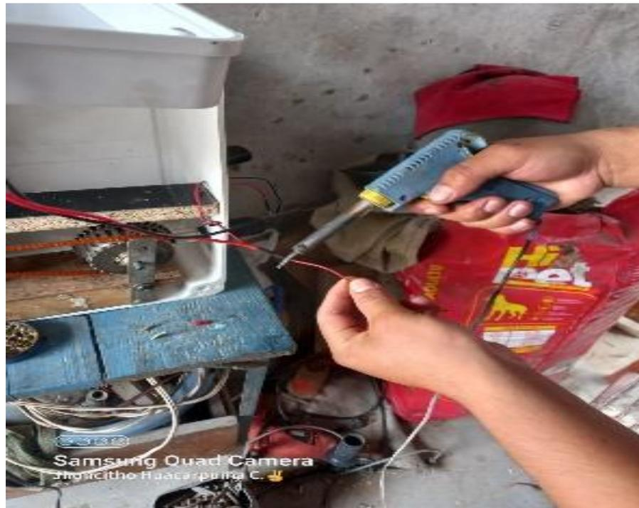
Instalación de sistema eléctrico del modulo probador de sensor CKP
