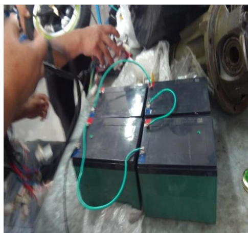
Figura 6. Instalación en serie de las baterías para comprobar el voltaje de operación (48Voltios)
