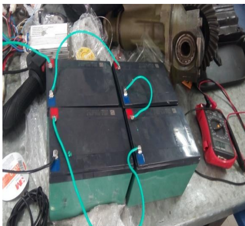
Figura 8. Componentes instalados del motor eléctrico
