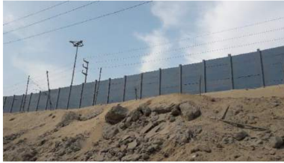
Figura 18. Instalación de mallas como cerco perimetral
