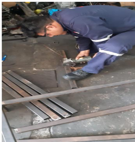
Figura 31. Cortado de tubos para el módulo.
