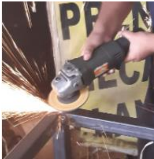
Figura 35. Desbastando estructura del módulo
