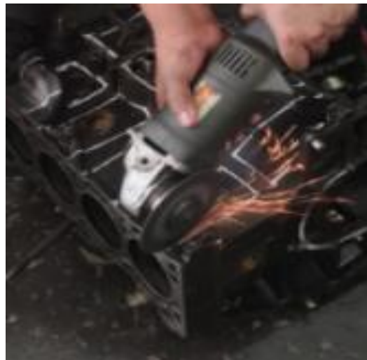
Figura 18. Cortando placa externa de bloque
