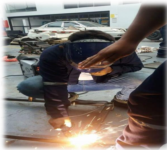
Figura N° 14. Soldando la estructura
