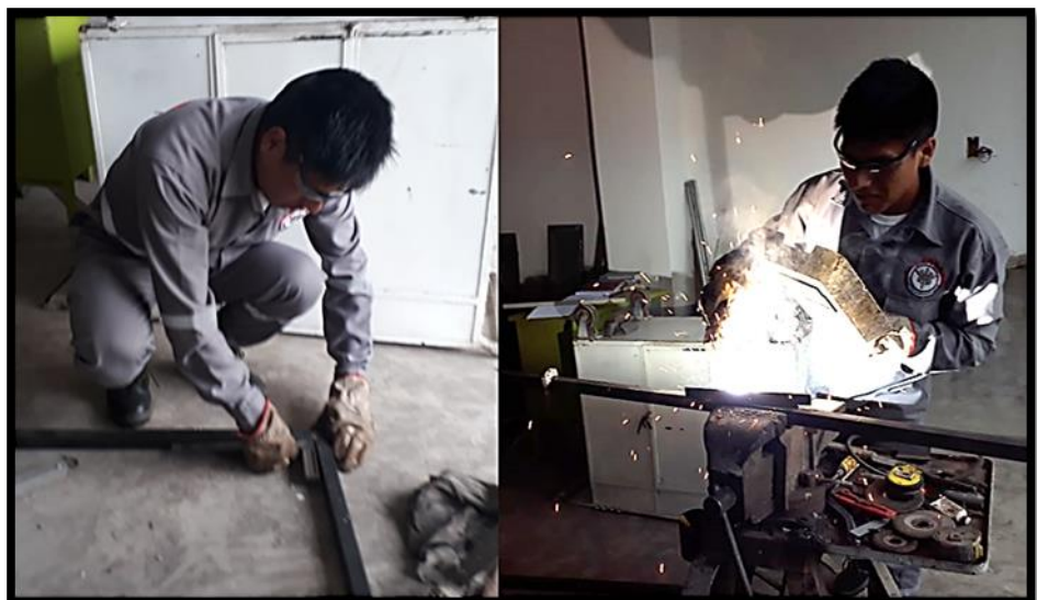
Figura 60. Construcción metálica de marco de puerta abatible
