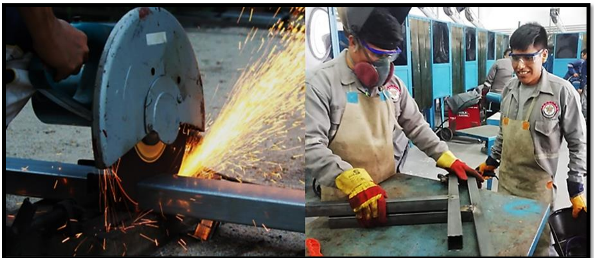
Figura 62. Construcción metálica de puerta abatible
