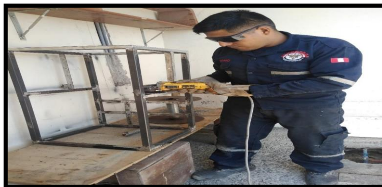
Figura 36. Reforzamiento y limpieza de la base rectangular del mecanismo.
