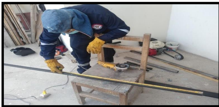
Figura 34. Presentación de medidas y cortes para la fabricación.
