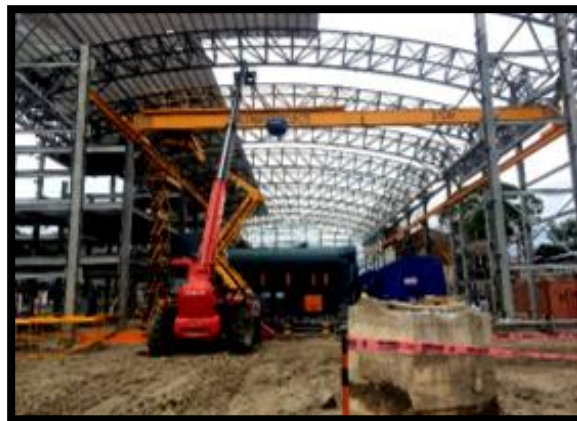
Figura 31: Cubierta curva (Perez y Huaman, 2019, p.20)
