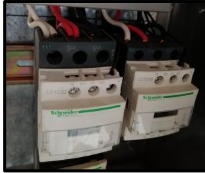
Figura 66: Contactores
