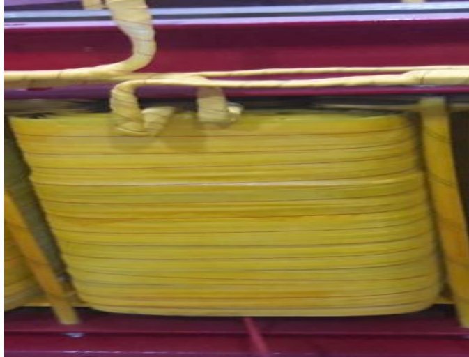
Figura 13. Transformador de aislamiento monofásico
