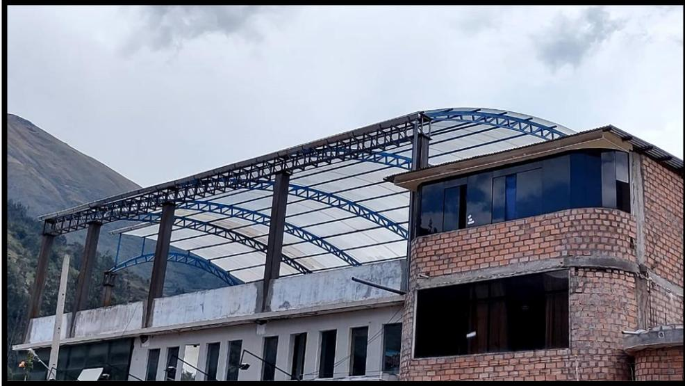
*Figura 9.* Techo de tipo arqueado con revestimiento de calamina
