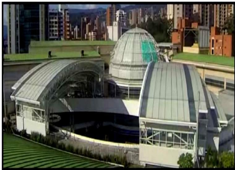
*Figura 4.* Techo retráctil de movimiento paralelo C (Villar, 2017, p. 11).
