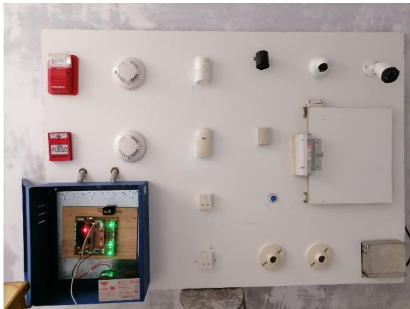
Figura 32. Prueba de funcionamiento de la tarjeta de control y los dispositivos
