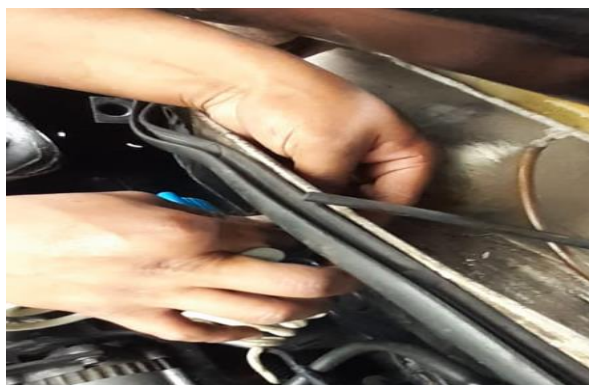
Figura 24. Instalando la válvula de suministro
