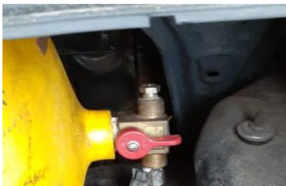
Figura 22. Instalando válvula de cierre
