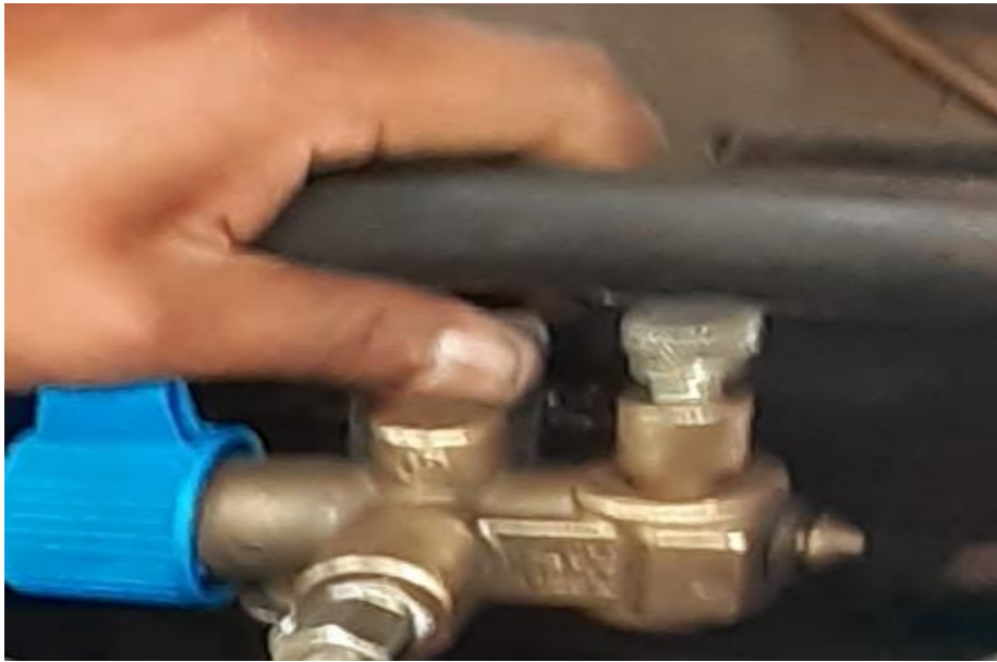
Instalando toma de carga de gas
