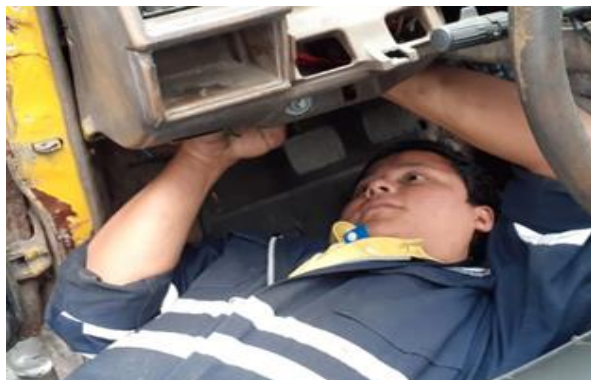
Figura 31. Cortando para colocar conmutador
