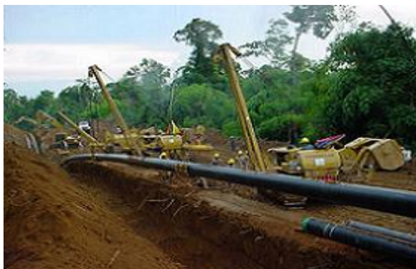
Figura 4. Instalación del gaseoducto (Mávila y Domus, 2016)
