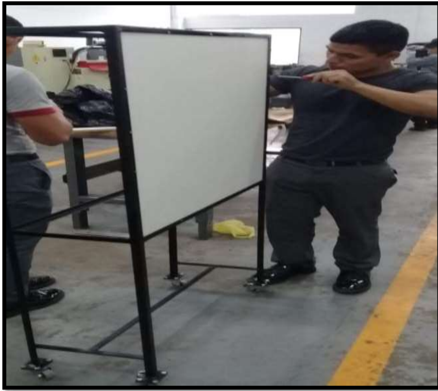
Imagen 49: Puesta del tablero a la estructura
