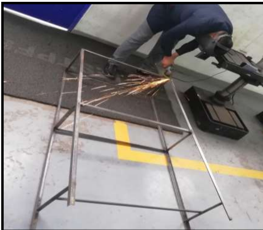
Imagen 48: Desbaste de soldadura de la estructura
