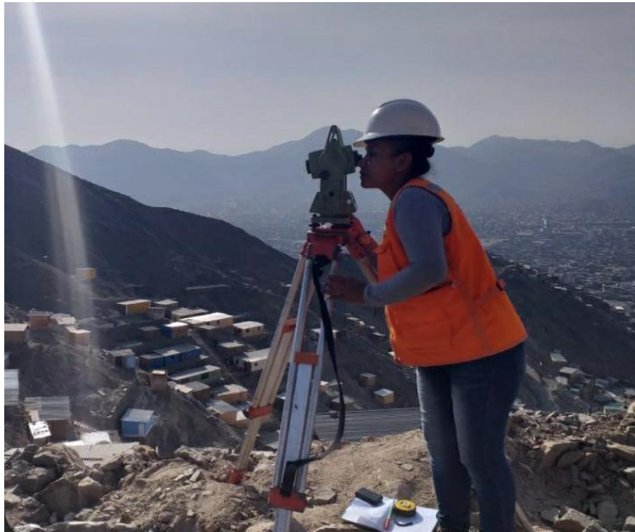
Foto N°12: Se observa, en la quinta estación ubicada en la calle SUKURA, donde se efectuó la ampliación de replanteo de lotes.
