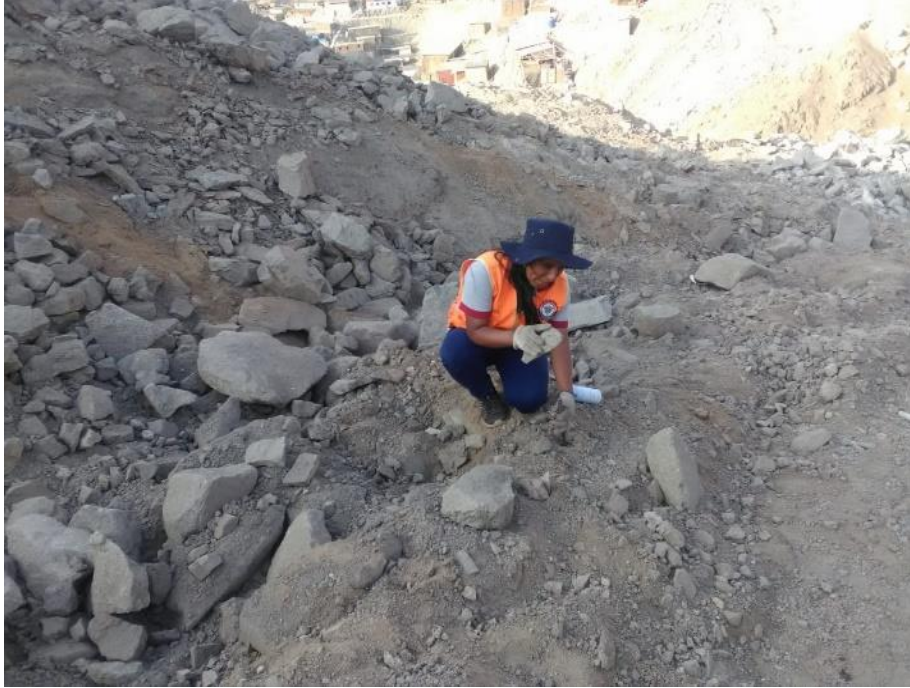
Foto N° 11: Colocación y materialización con estacas, de la MZ. S4 Lote 10, punto de vértice del lote, en la ampliación de la Agrupación Familiar San Antonio de Padua.
