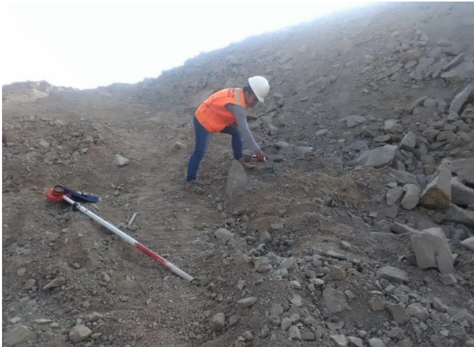
Foto N° 10: Se visualiza señalizando con pintura de spray la estaca, del vértice de la MZ. S4 Lote 10, en la materialización del punto.
