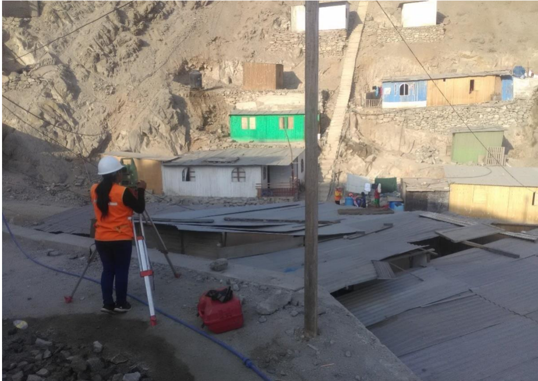
Foto N° 05: Segundo cambio de estación, en el pasaje LAS ADELFA, en la continuación del levantamiento topográfico y replanteo de lotes.
