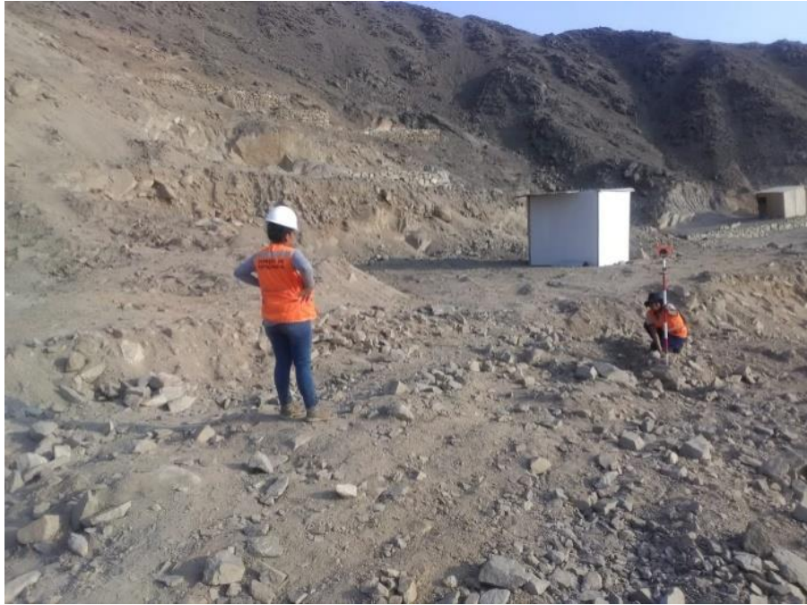
Foto N° 07: se observa replanteando la ubicación del vértice de la MZ. G2, lote 9; con la ayuda de la estación total.
