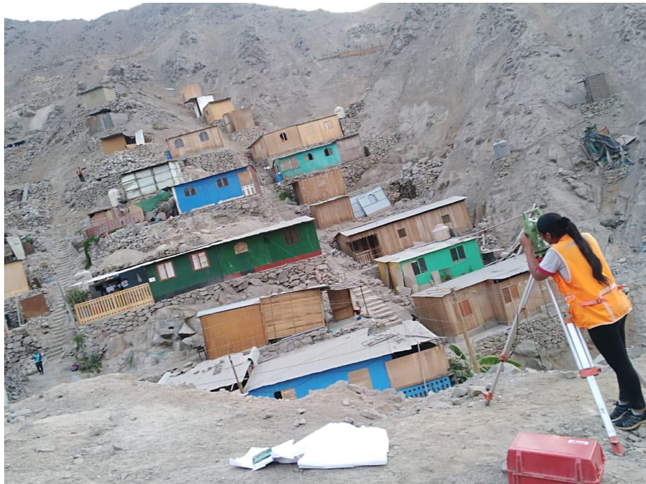
Foto N° 08: Ubicación de la tercera estación, en la manzana OF2 Uso de mercado realizando el replanteo y modificación de los vértices de las manzanas y lotes.
