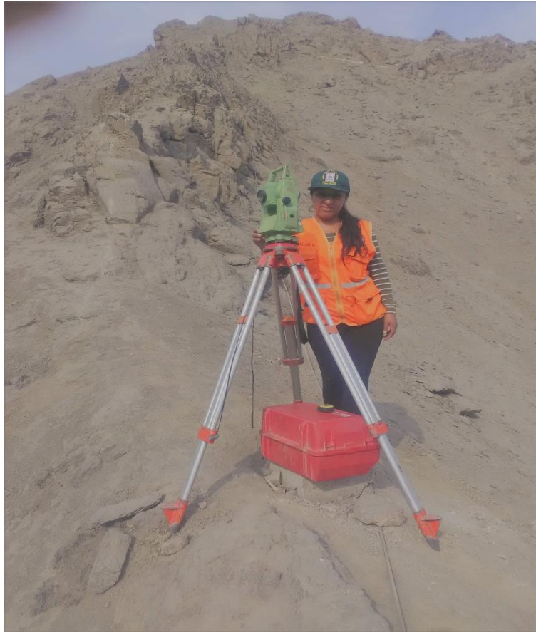
Foto N° 01: Se muestra al topógrafo estacionado en el punto de control LIMO1075.
