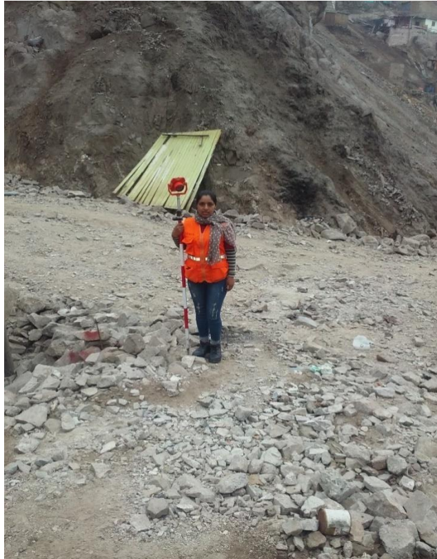
Foto N° 03: Se observa al asistente con el prisma en el vértice de la MZ A, LOTE 1.
