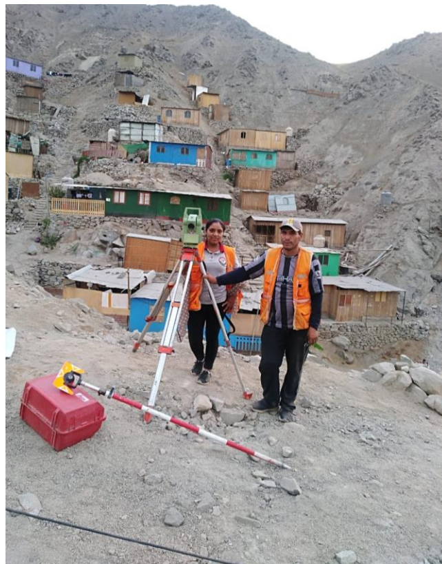
Foto N° 06: Ubicación de la Tercera estación en la ejecución de levantamiento topográfico y replanteo de lotes.
