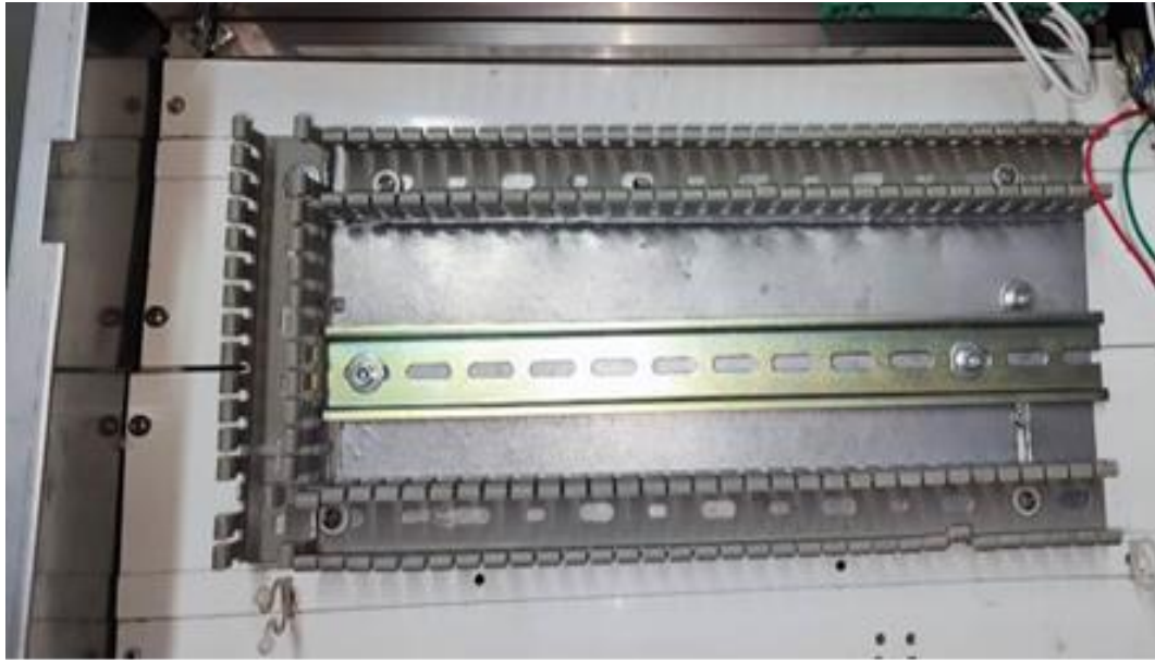
Figura 26. Se realizó el armado de la maqueta del tablero de control, incluyendo la colocación de las canaletas y rieles correspondientes en la hielera VENTUS.
