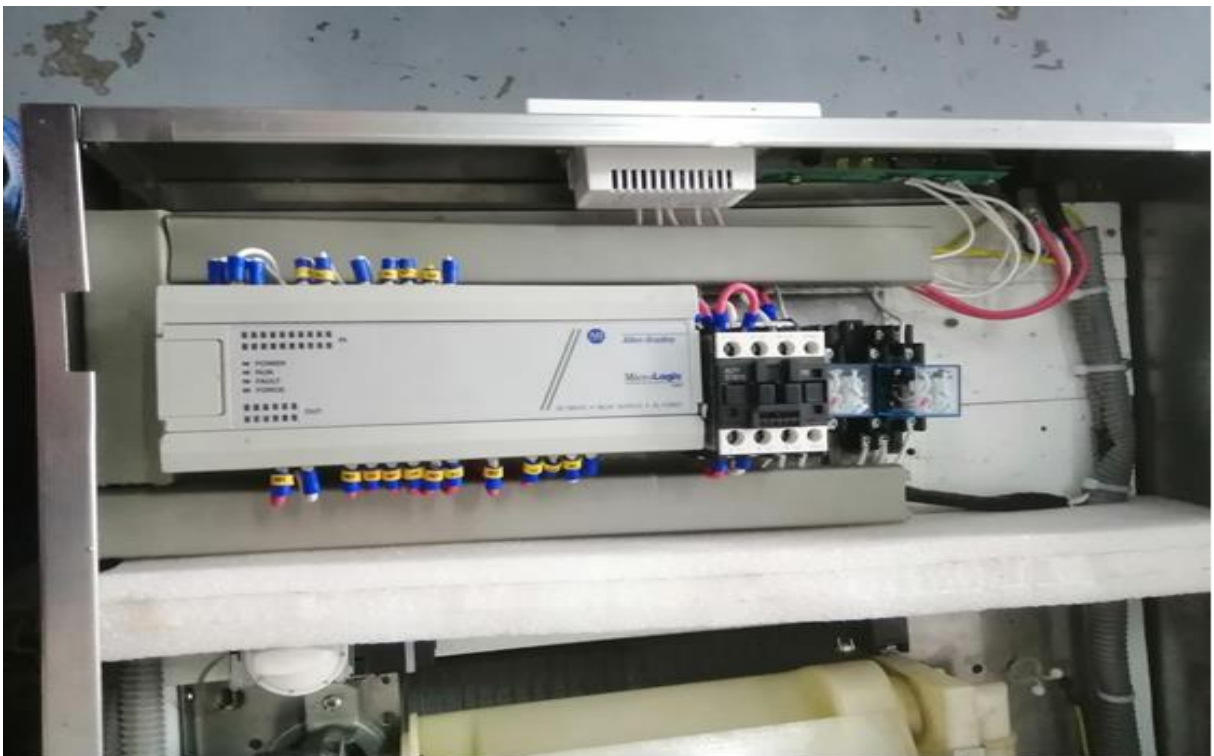
Figura 34. Se finaliza el cableado eléctrico siguiendo los diagramas de potencia y control, garantizando la correcta conexión de todos los cables. Se alcanza la etapa de finalización del tablero, donde se verifica y se asegura que el cableado esté completo y organizado de manera adecuada, para la hielera VENTUS.
